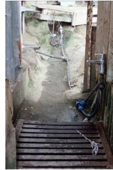
Photo 7 : Exemples de points d'eau tirés à partir de branchements de type spagettis
